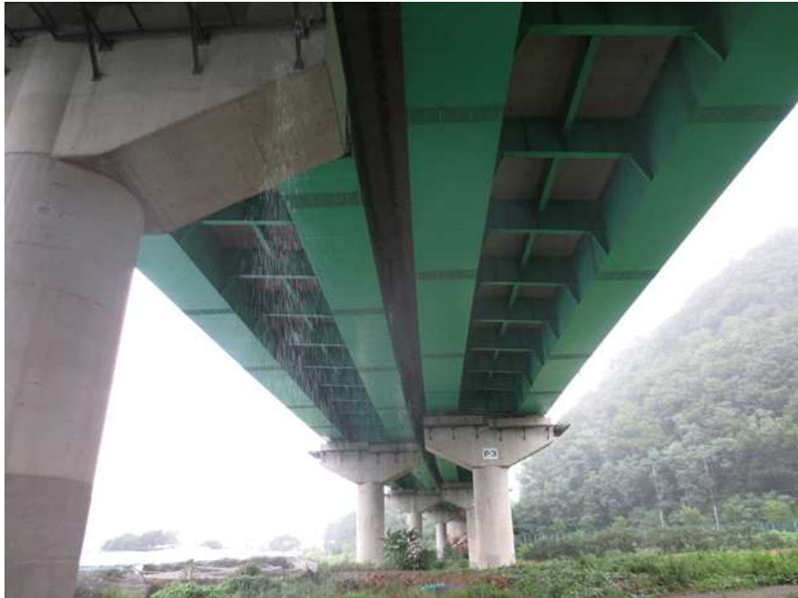
바닥판하면 및 강박스 외부전경
